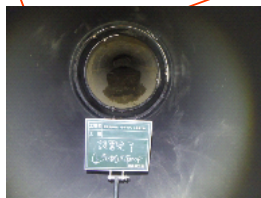
内面バンド設置後
