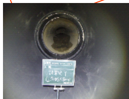
内面バンド設置後
