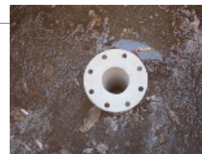
空気弁シール工
